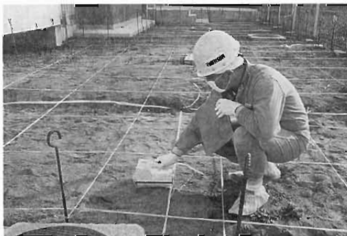
屋外の確認測定の状況
