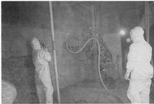
建家コンクリート表面除染の状況
